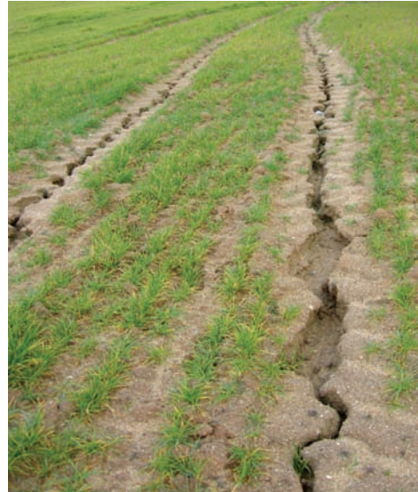
Foto 7. La imagen muestra la formación de regueros a lo largo de las rodadas del tractor (Arroyomolinos, Madrid).
